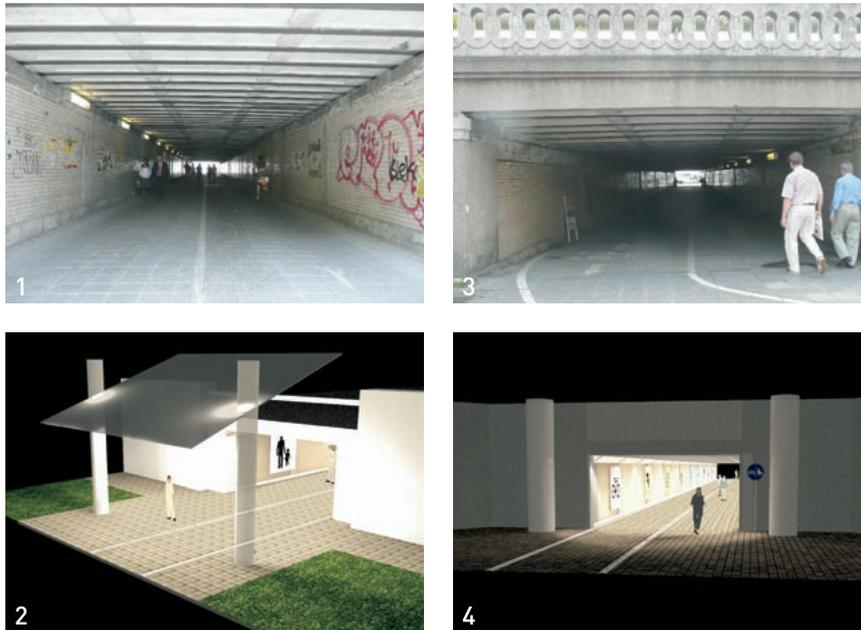
*Lichtgestaltung des Karl-Bröger-Tunnels. (1) Südseite Ist-Zustand, (2) Südseite geplante Ausleuchtung, (3) Nordseite Ist-Zustand, (4) Nordseite geplante Ausleuchtung.*
